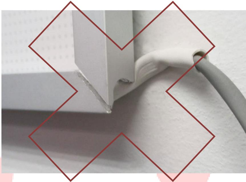
**WRONG APPLICATION OF CABLE POSITIONING**
